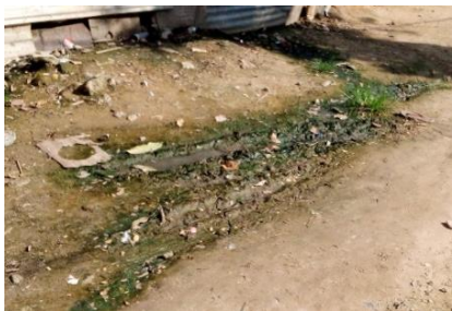
Photo 3 : Eaux usées dégoulinant dans la rue. Cliché Nzoumba, 2024
