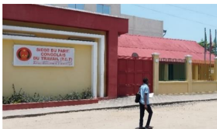
Photo 10 : Siège communal du Parti Congolais du Travail (PCT). Cliché Nzoumba, 2024
