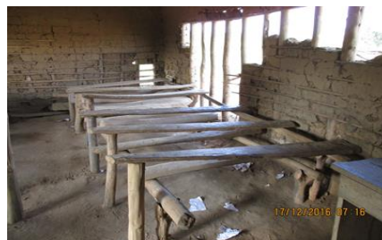
Photo 5 : État d'une salle de classe et des tables-bancs en matériaux locaux à Otini. Prise de vue Etoura-Iloky, 2016
