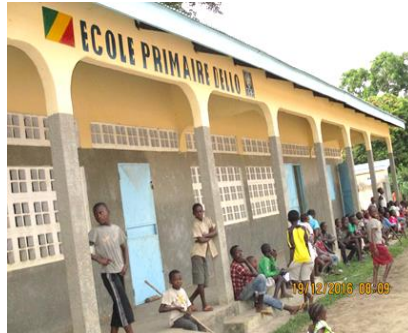
Photo 1 : Un bâtiment de l'école primaire d'Ello en matériaux durables. Prise de vue Etoura-Iloky, 2016
