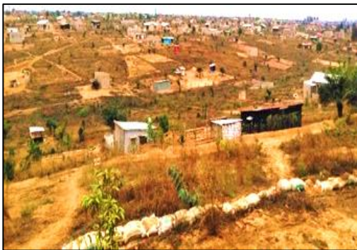
Photo 2 : Construction incontrôlée des bâtis au quartier Louéssi (prise de vue, Maketo, 2022)
