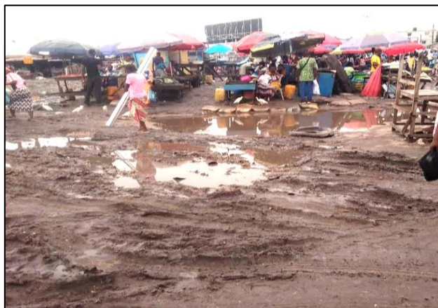
Photo 11 : Route dégradée à Fond Tié-Tié. Prise de vue, Maketo, 2024)
